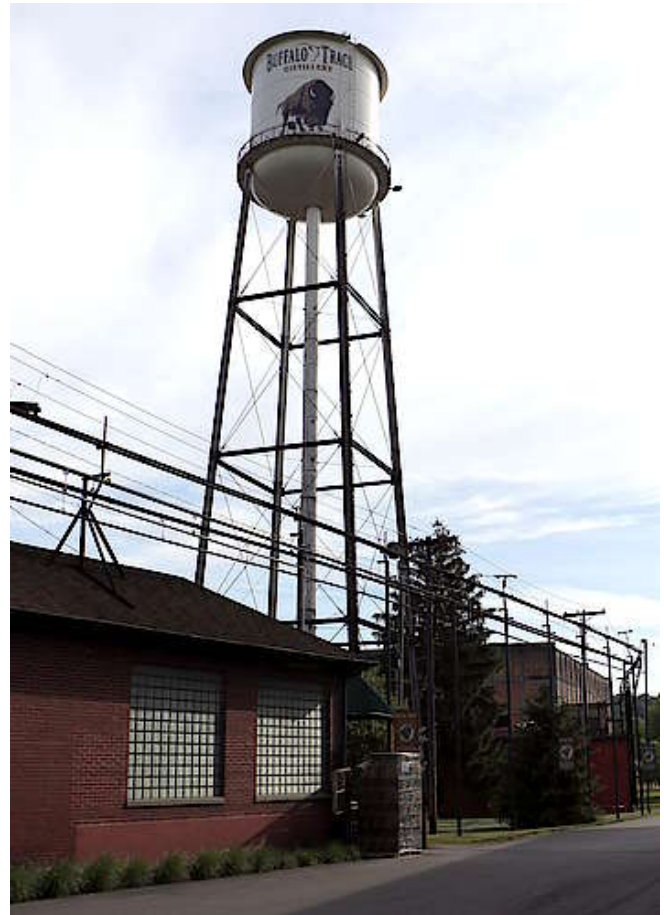
Wassertank von Buffalo Trace
